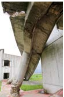
震災の傷跡が生々しく残っている石巻駅。未だ復興は進まず、がれきが残っている。
