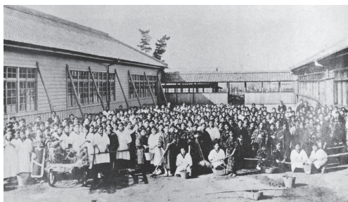
安城女子職業学校に初めてテニスコートが完成。 全校生徒が作業に携わった（昭和3年）
