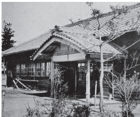
大正12年に建設された寄宿舎（舎監室および7室あり、生徒約50名が寄宿していた）
